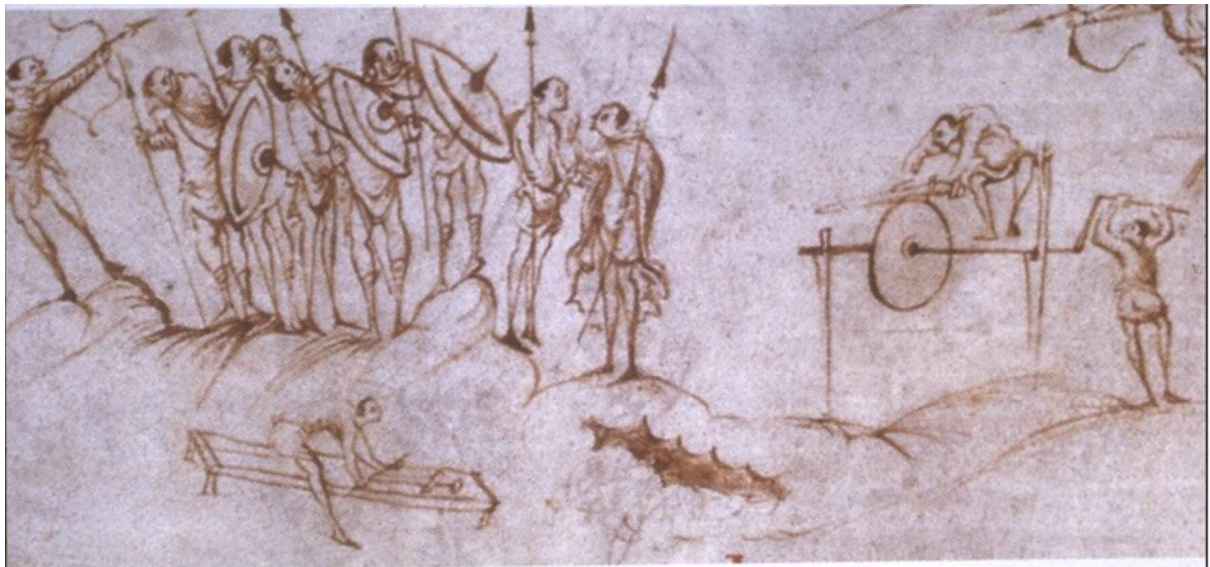
Abb. 3a: Illustration zu Psalm 63 aus dem Utrechter Psalter (um 820). Im Vordergrund sind zwei Klingenhändler abgebildet. Bei dem Handwerker über dem Drehschleifstein handelt es sich um einen Schleifer. Die Tätigkeit des Handwerkers, der ein - in einem Rahmen fixiertes - Schwert bearbeitet, ist einem Feinschliff- oder Polierstadium zuzuordnen.
